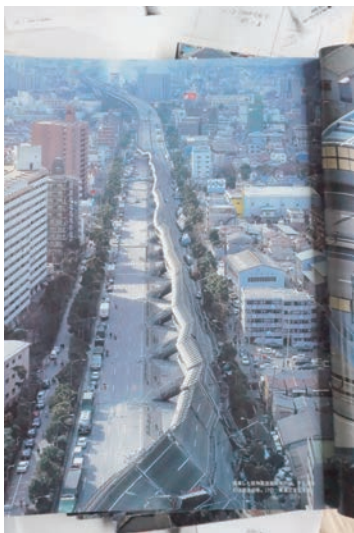
倒壊した阪神高速道路
