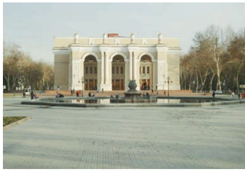
抑留元日本兵も協力して建設したナボイ劇場、左手奥に壁に経緯が説明書きされている。1990年のタシケント地震にも被害は少なかった。
